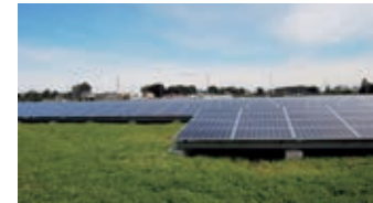
鶴ヶ島太陽光発電所
