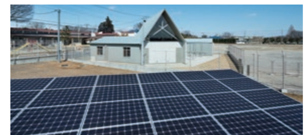
鶴ヶ島太陽光発電所
