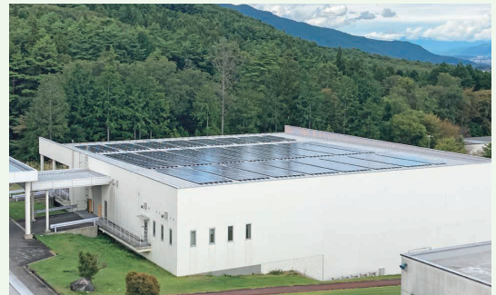
工場に設置した太陽光パネル
