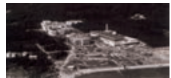
駒ヶ根工場建設中の風景
