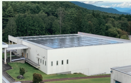
駒ヶ根工場に設置した太陽光パネル
