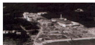
駒ヶ根工場建設中の風景
